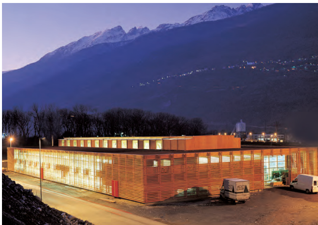
Realisierte Beispiele wurden vorgestellt, wie etwa ein schlankes, elegantes Fachwerk aus Esche für eine Schreinerhalle in Visp.
