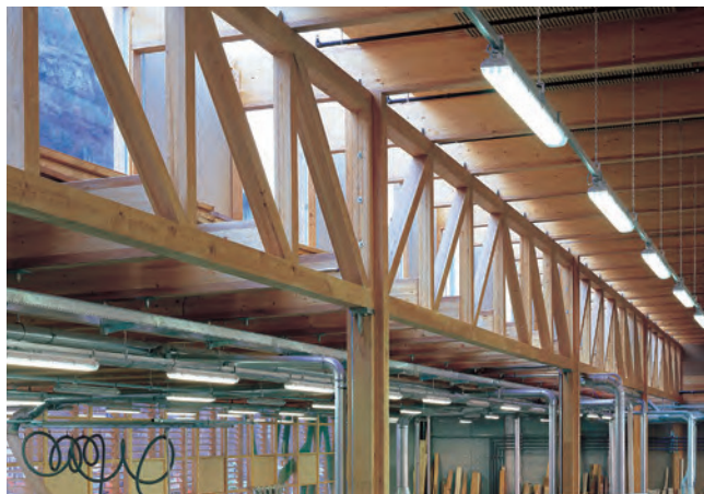
Realisierte Beispiele wurden vorgestellt, wie etwa ein schlankes, elegantes Fachwerk aus Esche für eine Schreinerhalle in Visp.
