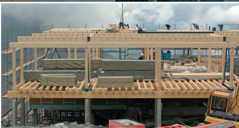
Restaurant in Saas Fee: Die grossen Lasten werden mit Trägern abgefangen, deren Querschnitt lediglich 24 mal 24 cm (Einleitung von 800 kN) misst.
