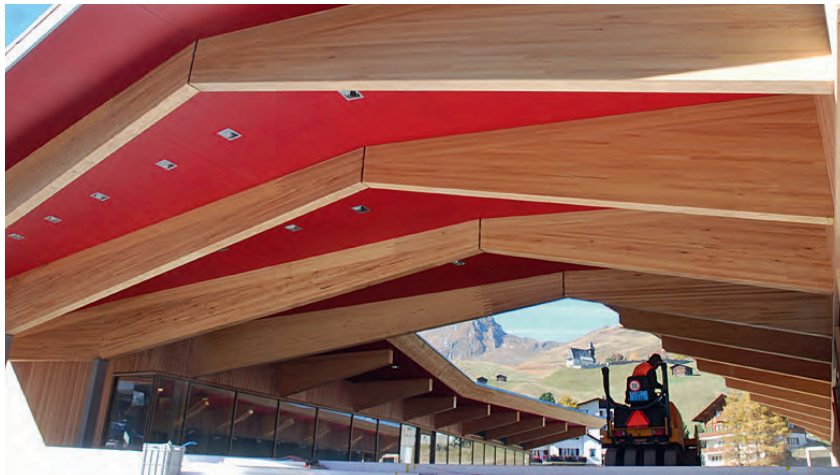
Die grosse Schneelast musste bei diesem Gewerbeobjekt in Arosa besonders berücksichtigt werden.
