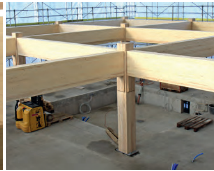
Der Skelettbau des ETH-Holzhauses besteht aus einem Stützenraster (6,5 mal 6,5 m) aus Eschenholz.
